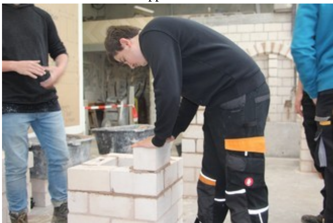
Ein Schüler der PMHS errichtet ein Sichtmauerwerk.
